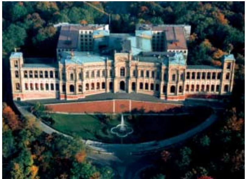
Blick auf die Westfassade des Maximilianeums
